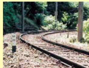
箱根には急勾配だけでなく、カーブもたくさんあります。最も急なカーブはR30(曲線半径30メートル)ほどで、まるで直角に折れ曲がるようです。この急カーブを安全に運行するために、登山電車の車体は短くできています。ちなみに新幹線は25mありますが、登山電車は1両15mたらずしかありません。
